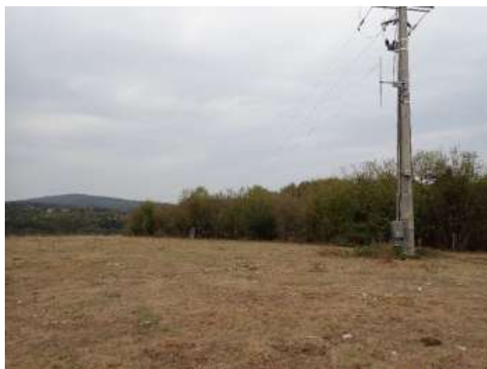
Figure 26 : Ligne électrique sur la RNR de la Grotte de Chenecey
