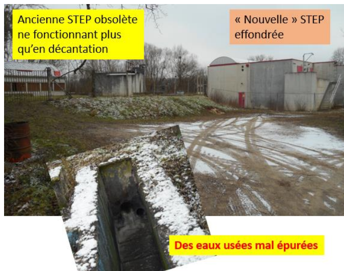
La station dite « d'épuration » d'Emagny (25).
