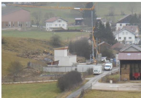
La station d'épuration d'Avoudrey en chantier (2016)
