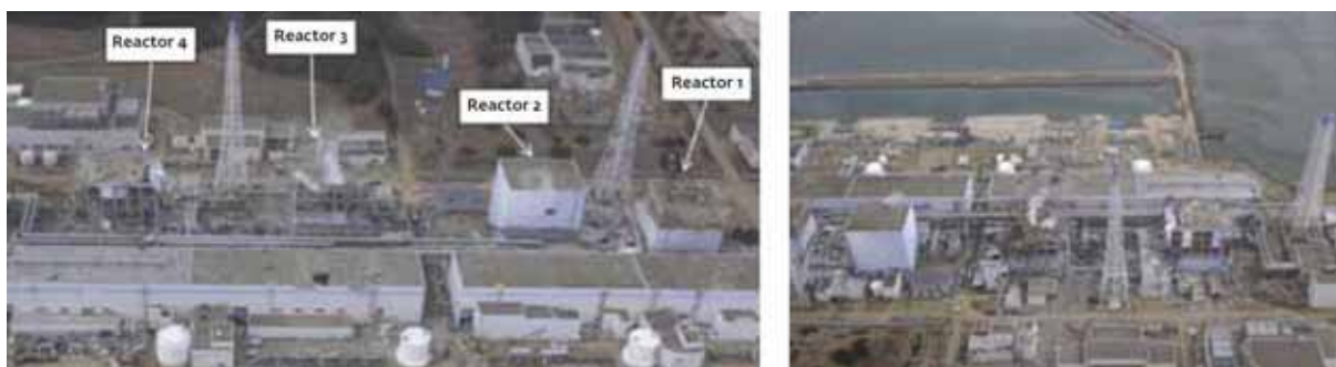
▲ Vue des bâtiments réacteurs après les explosions
