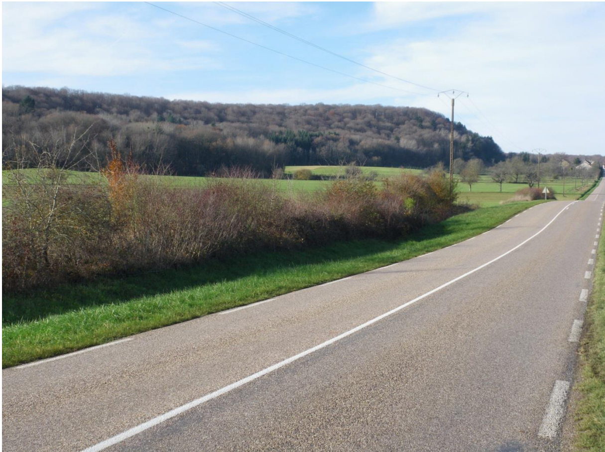
Exemple le long de la RD 3 à SCEY-SUR-SAONE-ET-SAINT-ALBIN avant intervention
