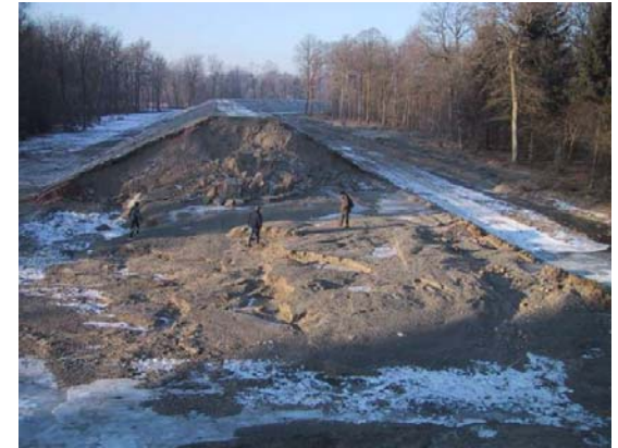
De Nantes à Montaigu... la digue a rompu !
