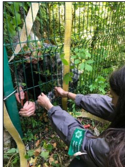
Figure 2019 : Réparation du grillage de Chenecey.
