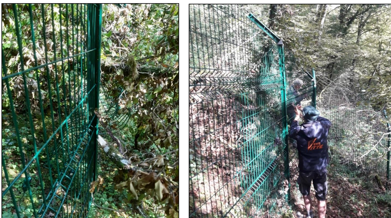
Figure 21 : Réparation du grillage autour de la cavité de la RNR Grotte de Beaumotte.
