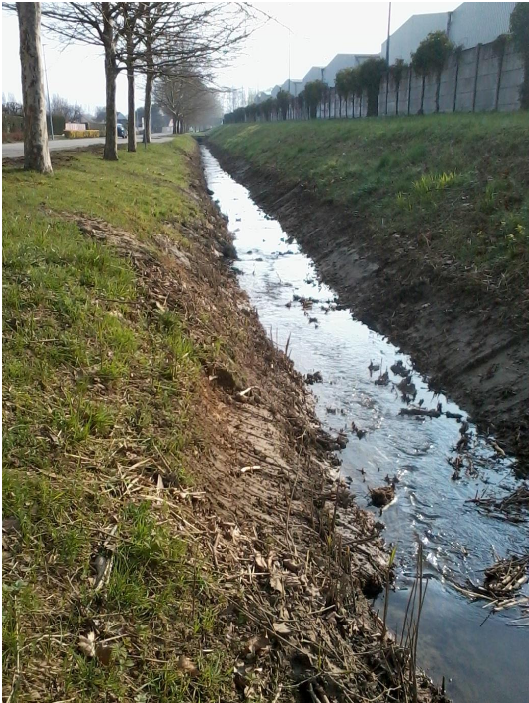
En direction de l'aval
