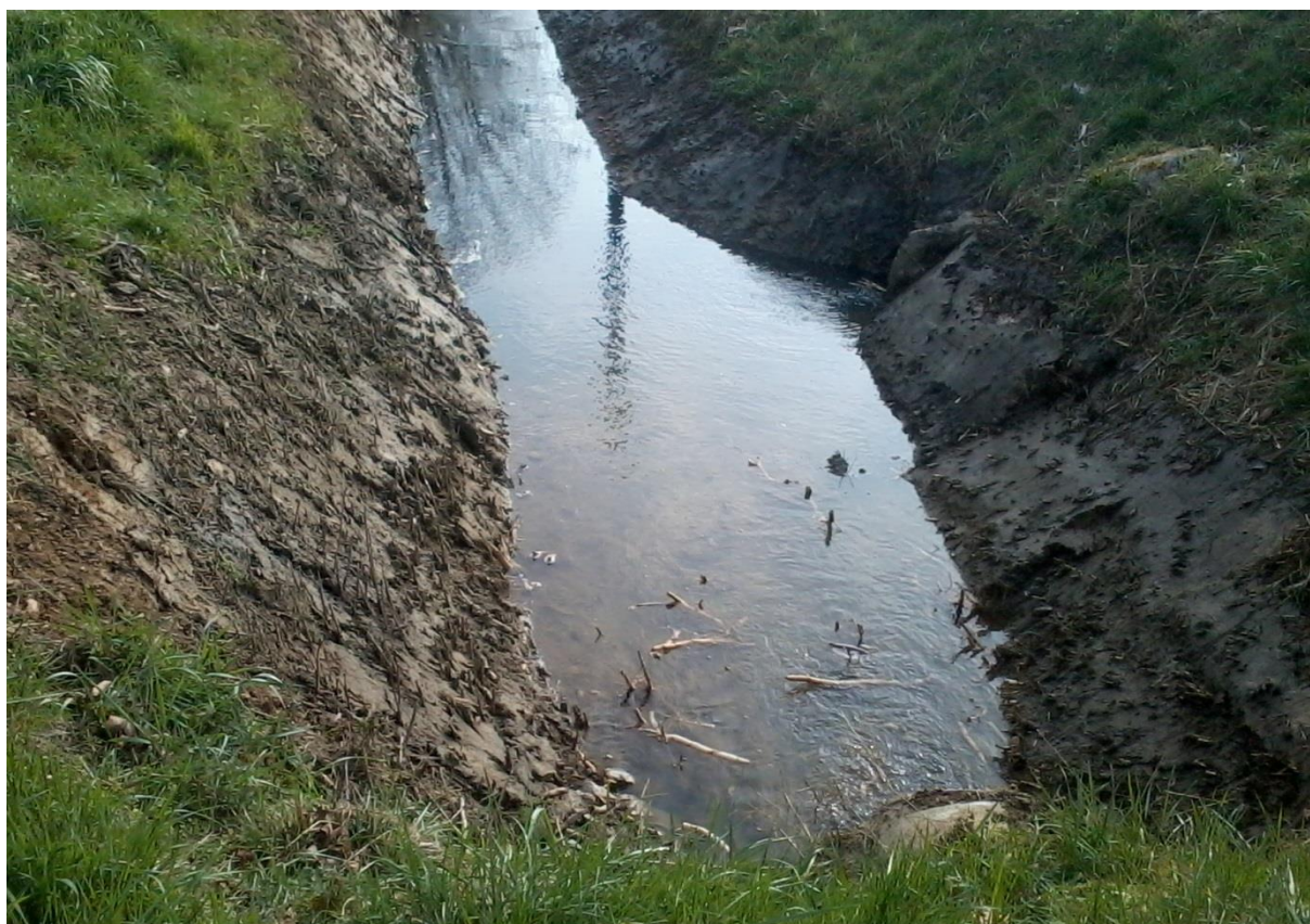
Ci-dessus et ci-après partie amont de la portion de ruisseau curé (© CPEPESC FC, 23 mars 2026)
